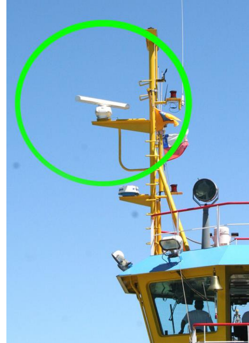
Antena de radar marítimo
